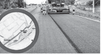
Строительство водопроводных сетей
